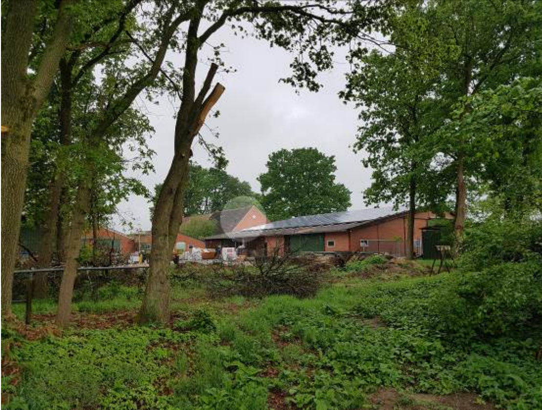
Abbildung 6: Überplante Bebauung der Hofstelle: Im Hintergrund mit schadhaften Stellen im Dach im hellen Kreis
